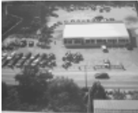
Edifício comercial Água Longa Lojas / oficina e escritórios
