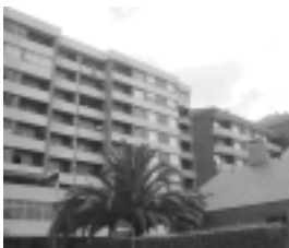
T2+1 Santo Tirso Totalmente remodelado
