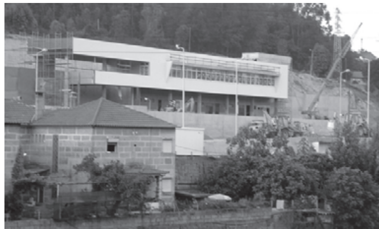
A nova estação ferroviária de Caniços, S. Pedro de Bairro
