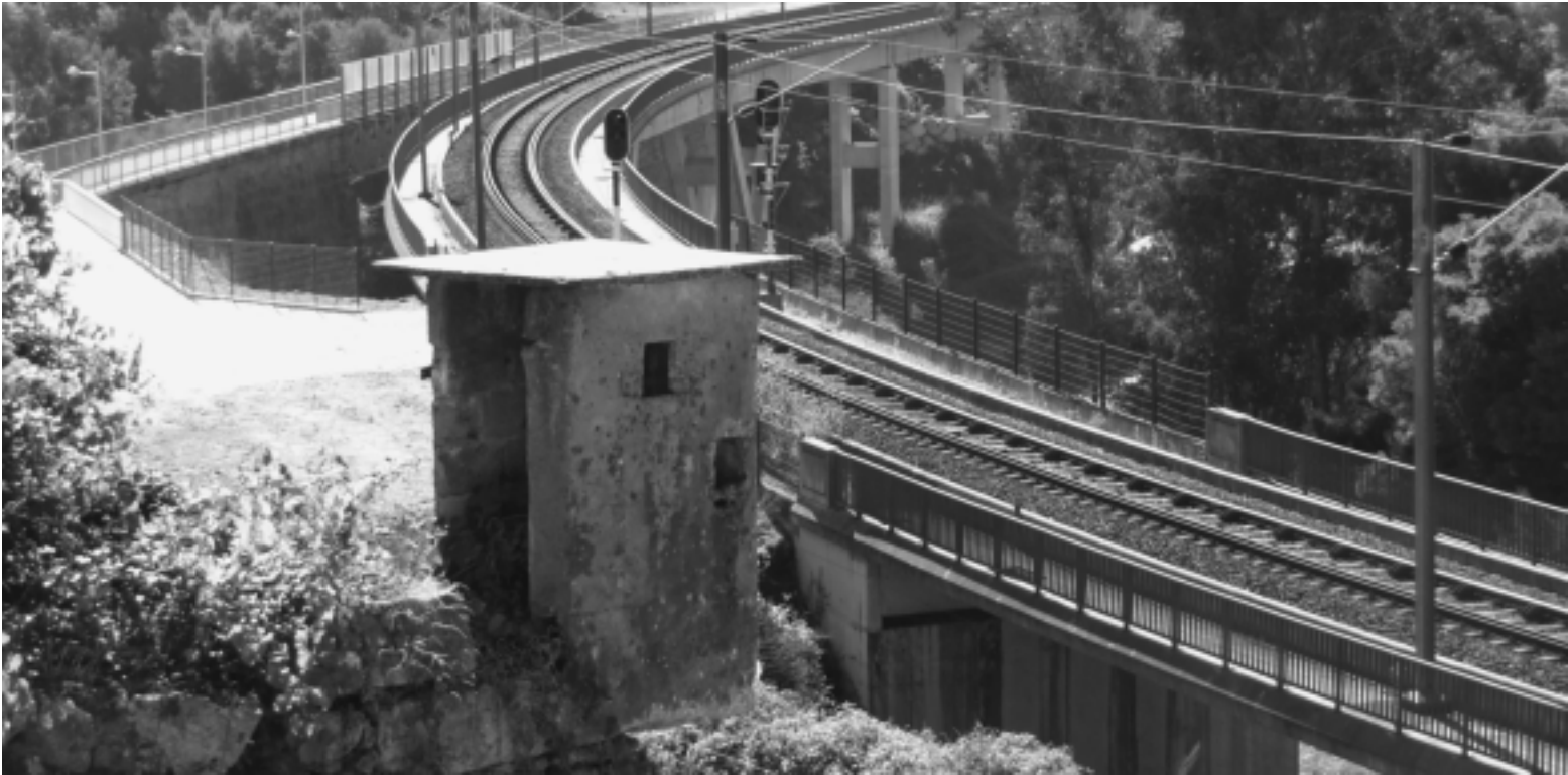
PONTE FERROVIÁRIA DE CANIÇOS ENTRE VILA DAS AVES E S. PEDRO DE BAIRRO (FAMALICÃO)
